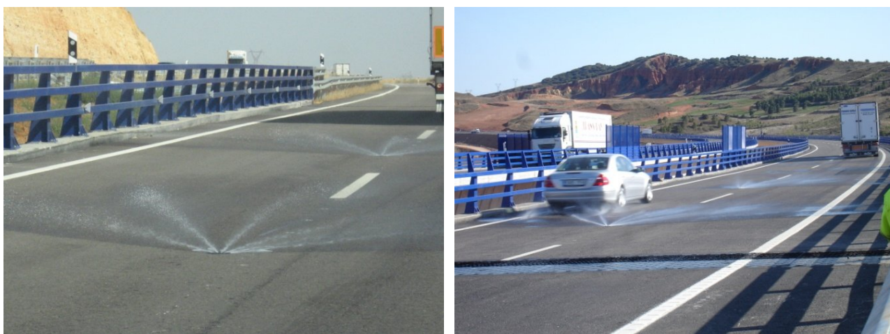
Distribución de aspersores en la calzada. Taladros en asfalto para su instalación. Funcionamiento.
