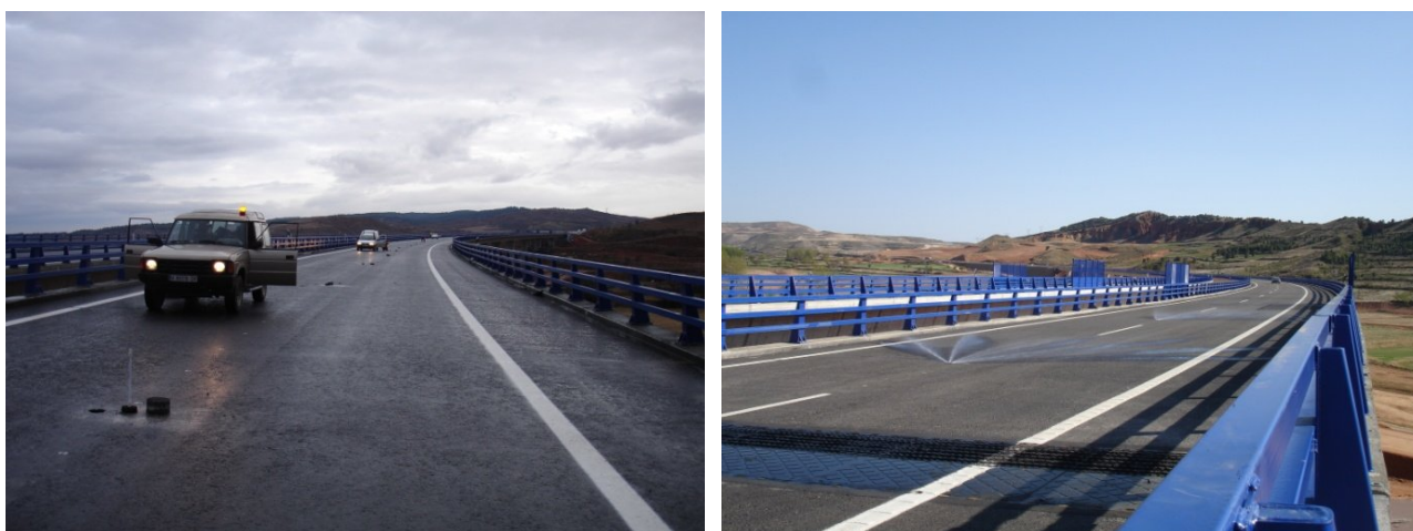
Distribución de aspersores en la calzada. Taladros en asfalto para su instalación. Funcionamiento.
