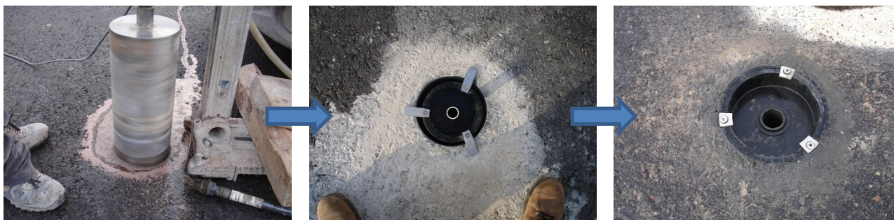
Montaje de aspersores embebidos en la calzada.
